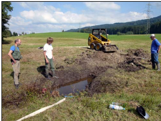
Abb. 27: Im nordöstlichen Randbereich wurde das Terminalstück einer Drainage ausgedohlt. 13.09.2005
