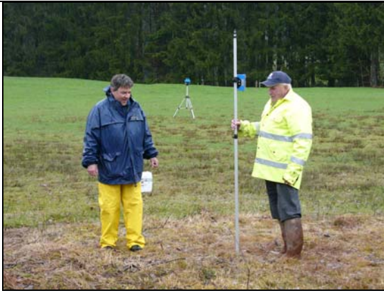
Abb. 4a und 4b: Um die exakten Standorte der Spundwände festzulegen, erfolgte ein Flächenlaser-Vermessung, und Positionen der Spundwände wurden verpflockt. (in Abb. 4a, rechts: Alois Zahner; er stellte den Flächenlaser und seine eigene Arbeitszeit unentgeltlich zur Verfügung; Abb. 4a links und Abb. 4b: Ch. Meienberger) 08.04.2005
