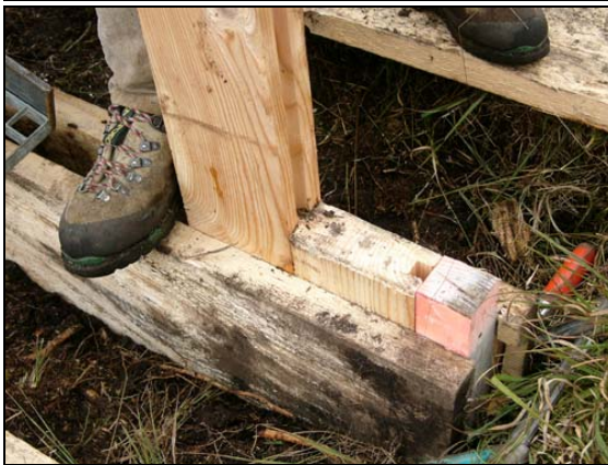
Abb. 15 und 16: Details zum Rammvorgang und zur Konstruktion. Alle Bohlen waren beidseits genutet. Zur Abdichtung wurde eine separate Feder eingelegt und befestigt. Diese Vorgehensweise steht im Zusammenhang mit den technischen Möglichkeiten der mit der Holzaufbereitung beauftragten Sägerei. 20.09.2005
