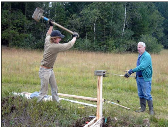
Abb. 13: Besonders schwierig war das Einrammen der ersten Bohle einer Spundwand. Der Beginn erfolgte mit den Zaunschlegel. Zum Schutz der Bohlen vor dem Zersplittern kam ein Schutz aus Eisen zum Einsatz. 28.8.2005
