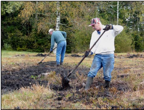
Abb. 23: Torf wird von Hand eingefüllt, und auch die Vegetationsziegel werden von Hand gesetzt. 20.10.2005
