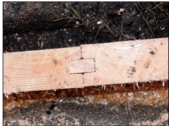
Abb. 15 und 16: Details zum Rammvorgang und zur Konstruktion. Alle Bohlen waren beidseits genutet. Zur Abdichtung wurde eine separate Feder eingelegt und befestigt. Diese Vorgehensweise steht im Zusammenhang mit den technischen Möglichkeiten der mit der Holzaufbereitung beauftragten Sägerei. 20.09.2005
