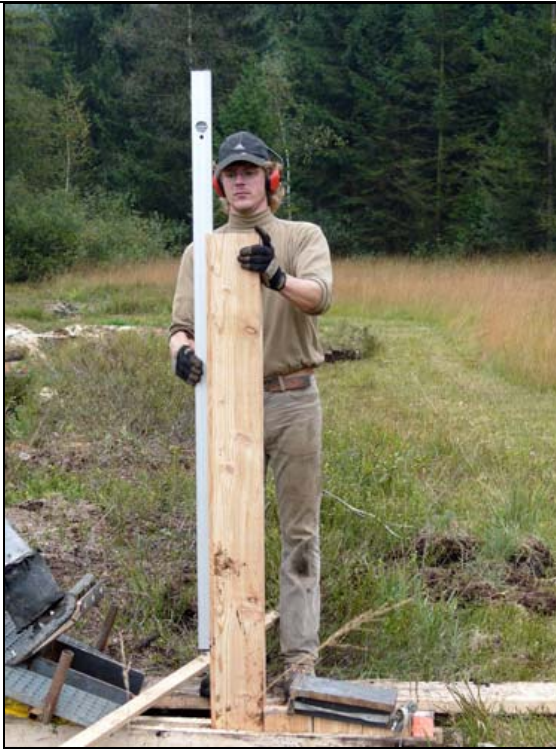
Abb. 14: Die Bohlen mussten im Lot eingerammt werden, damit Nut und Feder sauber ineinander passten. Hier erfolgt eine Kontrolle mit der Wasserwaage. 20.09.2005
