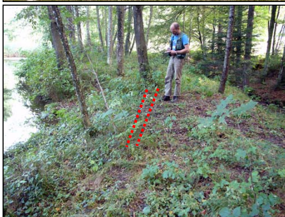
Abb. 28: Dieser Damm des Stauweihers verhinderte bei Hochwasser einen Überlauf ins benachbarte Bächlein, was zur Folge hatte, dass das Hochmoor bei starker Wasserführung überflutet wurde. Im Einvernehmen mit dem Grundeigentümer konnte ein Überlauf eingebaut werden, der ein Überfließen ins Hochmoor verhindern soll. 13.09.2005
