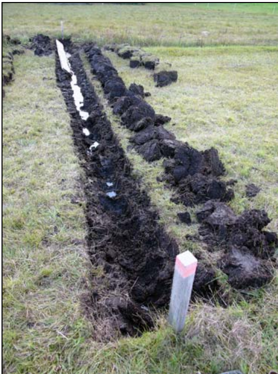
Abb. 10: Nach dem Einschneiden des Moorbodens mit der Kettensäge wurde der Torf in Ziegeln herausgehoben und seitlich deponiert. 21.09.2005
