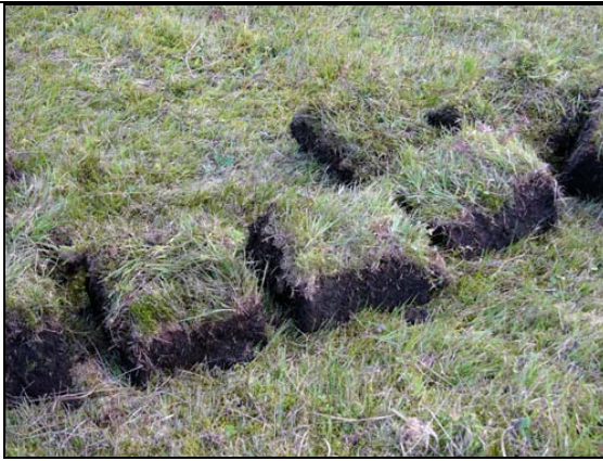
Abb. 11: Die Vegetationsziegel wurden sorgfältig beiseite gelegt, um sie am Ende wieder zurücklegen zu können. 20.09.2005
